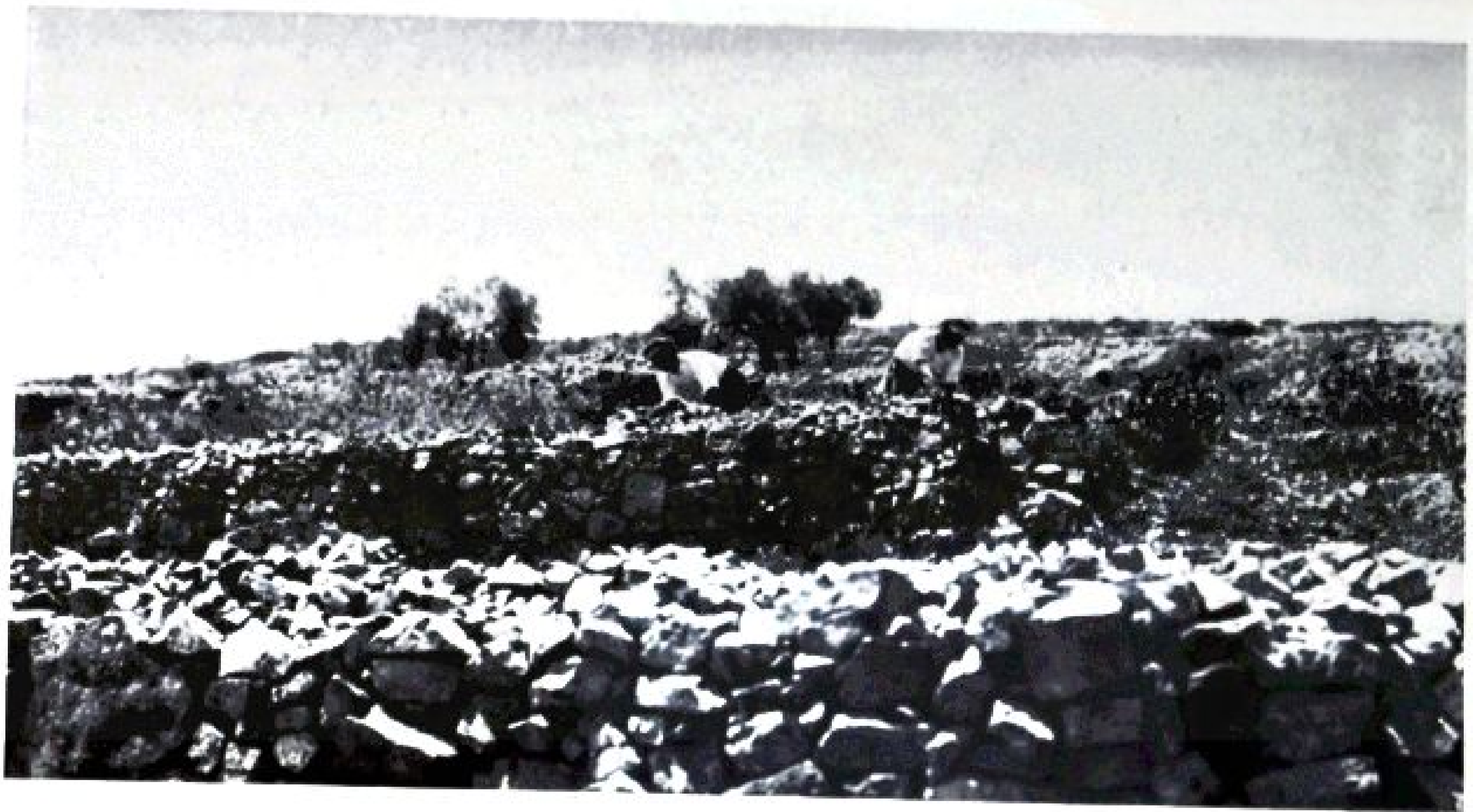
Kirjath Anavim. Aanleg van terrassen.
