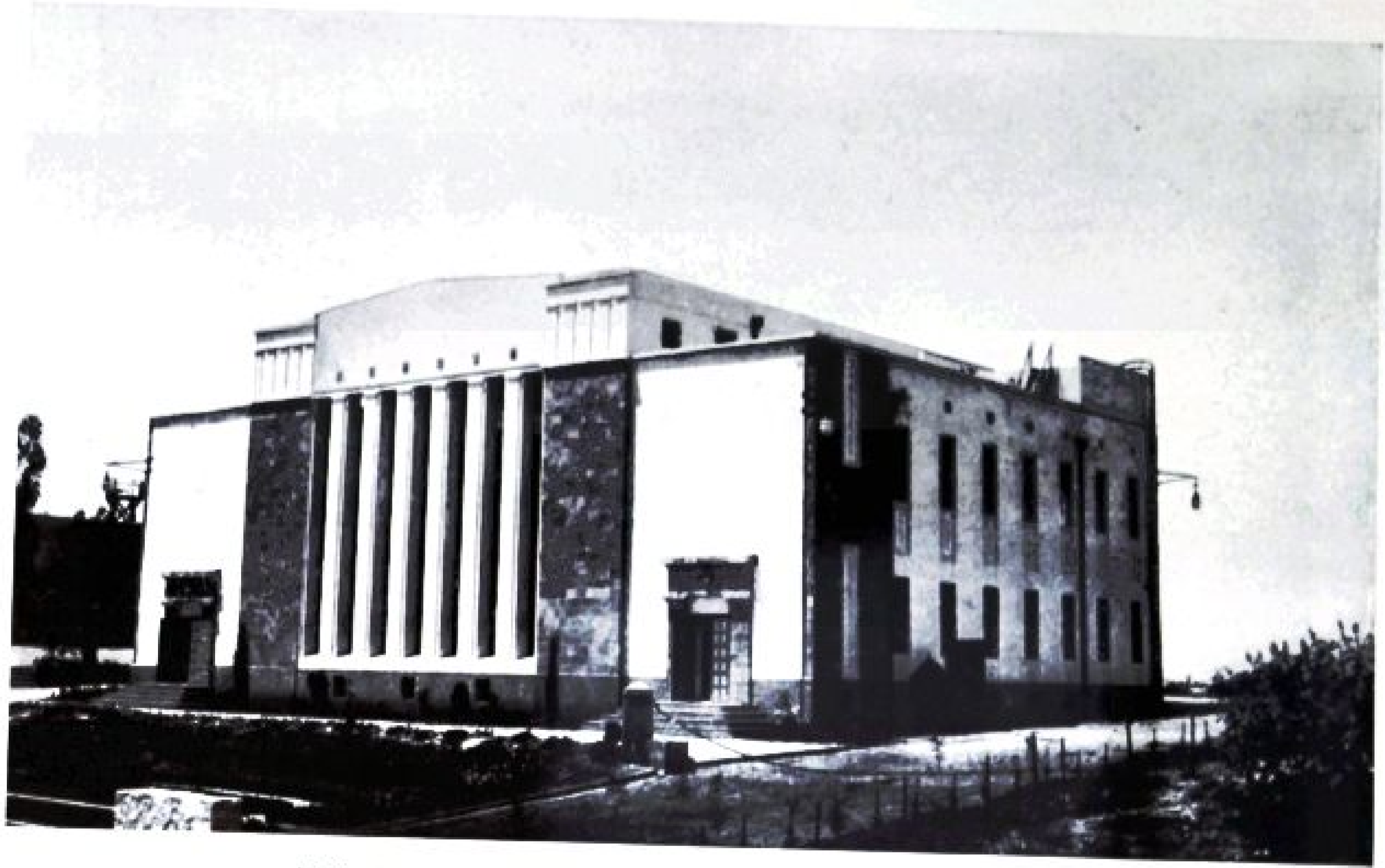
Tel Aviv. Electricische Centrale van Ruthenberg.
