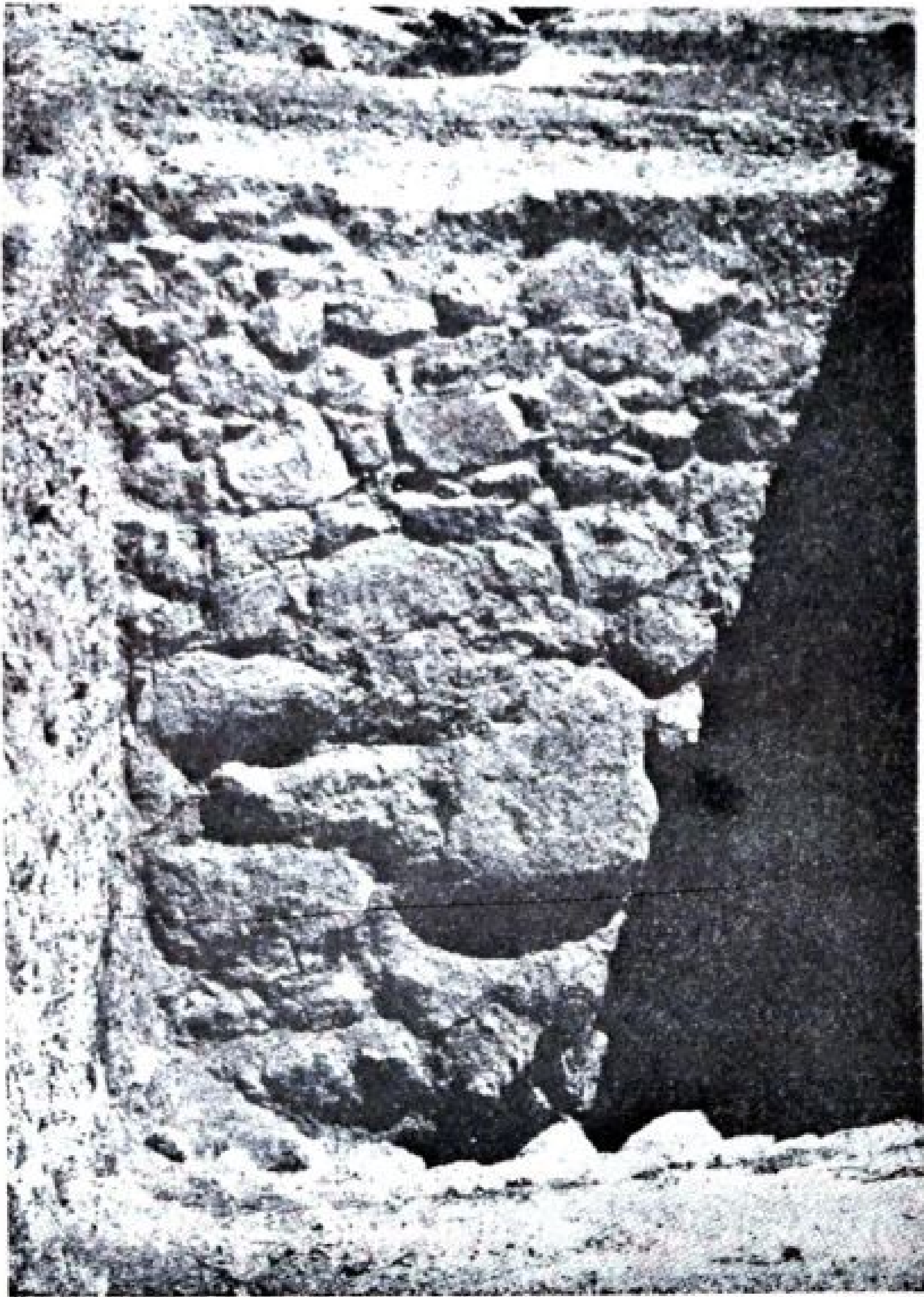
Abb. 32. Die Böschungsmauer im Südschnitt, in K 2, von Westen gesehen.
