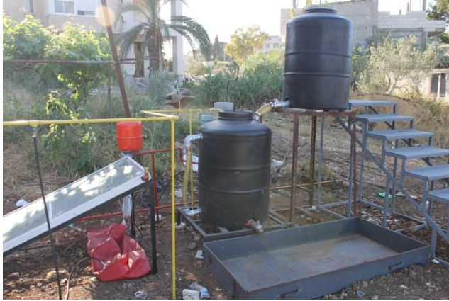
a. Biogas plant anterior
