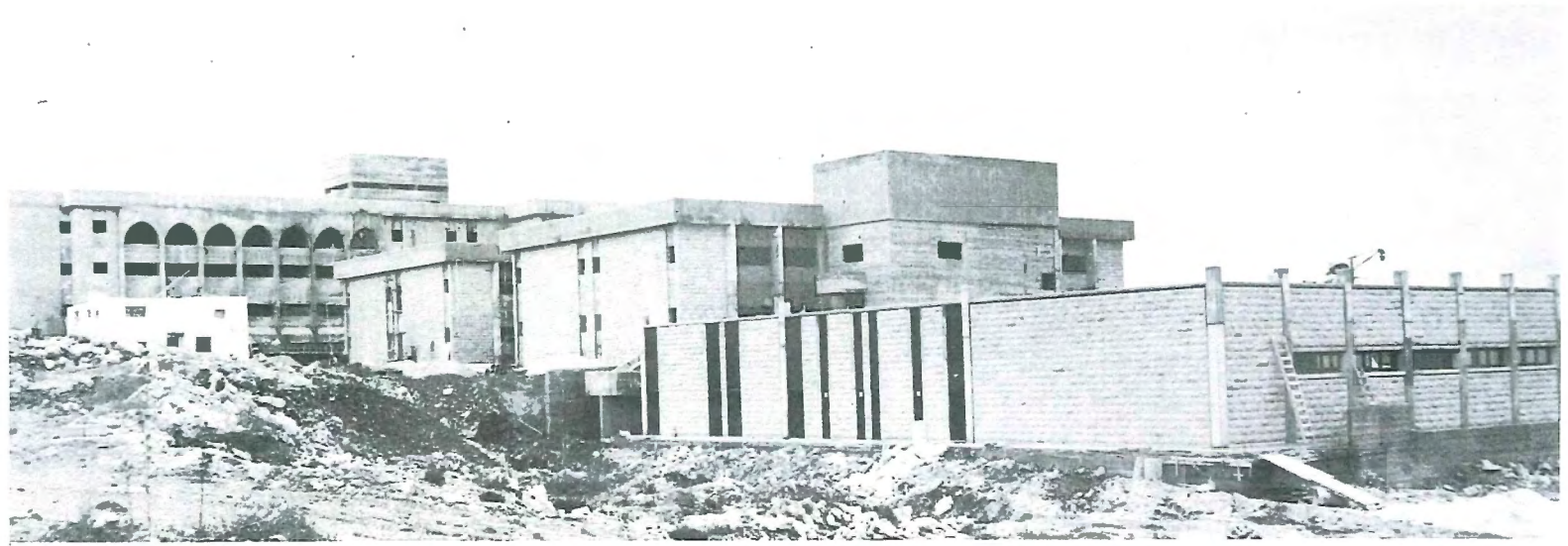
كلية الهندسة في المراحل الأخيرة من البناء
