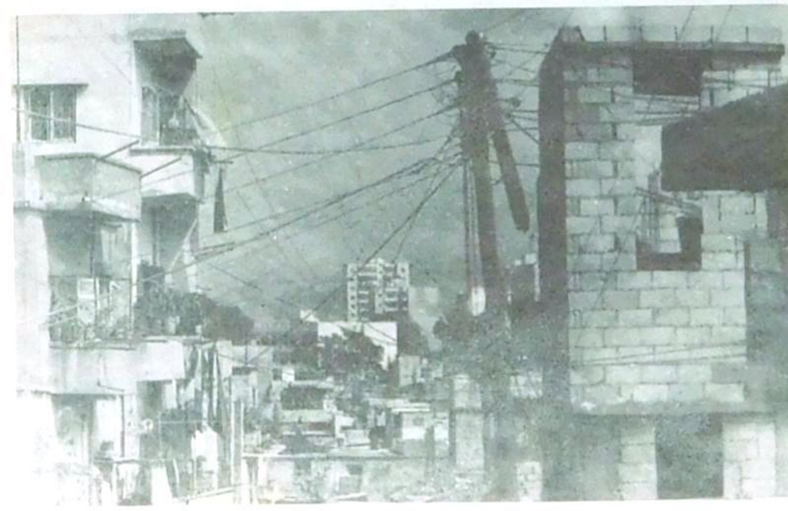
خطوط نقل الكهرباء في مخيم شاتيلا
