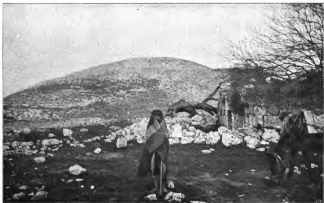
55 Ruinen von Silo
