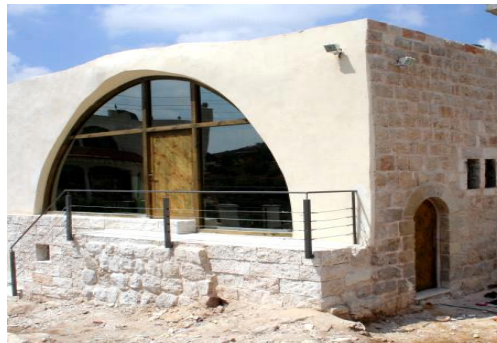
صورة (102): المركز المجتمعي بعد الترميم، موقع فلسطين من الذاكرة.
