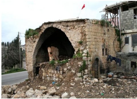
صورة (101): المركز المجتمعي قبل الترميم، موقع فلسطين من الذاكرة.
