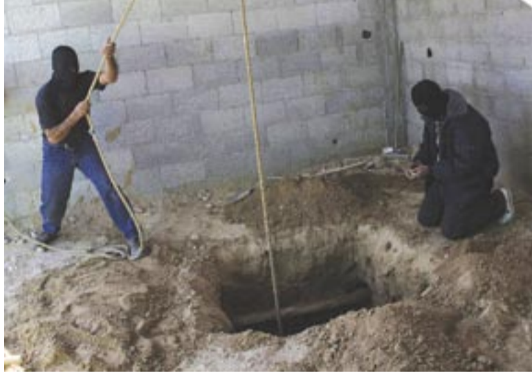
أعمال حفريات في احد الانفاق.
